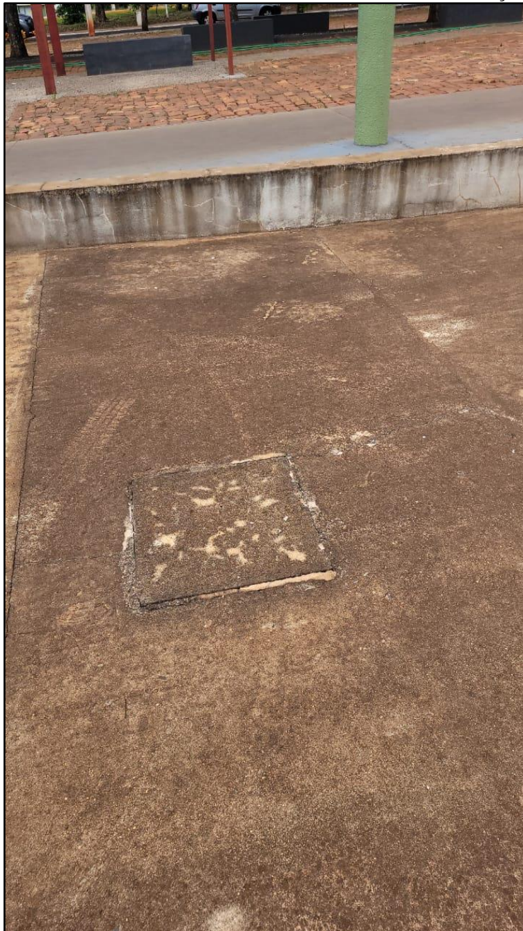
Figura 11. Caixa de telefonia a ser rebaixada devido movimentação de terra
