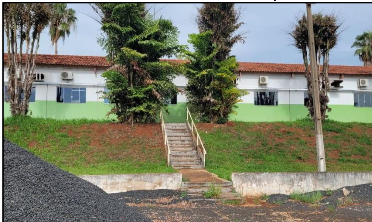
Figura 8. Escada existente - acesso na lateral esquerda a ser demolida
